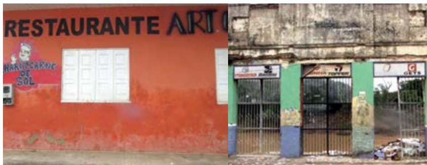
Fotografía 20: Nivel de la inundación y afectación en las viviendas, Brasileia.
